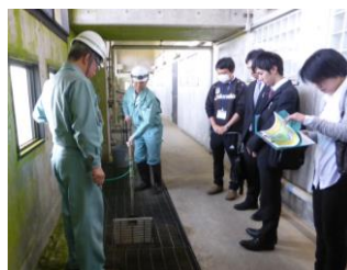
<入善浄化センター>
